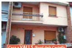
Casa a VALLS / Barri dels Castells
